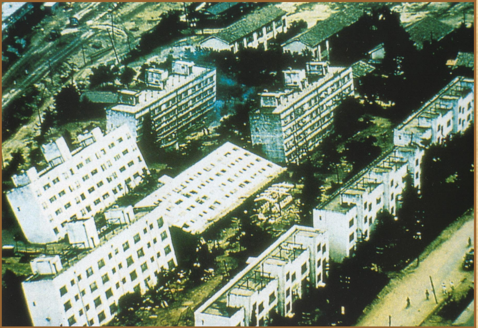
Şekil 9.16: 1964 depremi sırasında Japonya, Niigata'da bu binaların çökmesi, suya doymun toprak üzerindeki yer sarsıntısı etkilerine dramatik bir örnektir. Depreme dayanıklı olarak tasarlanan binalar oldukları yerde yana yatmışlardır.
