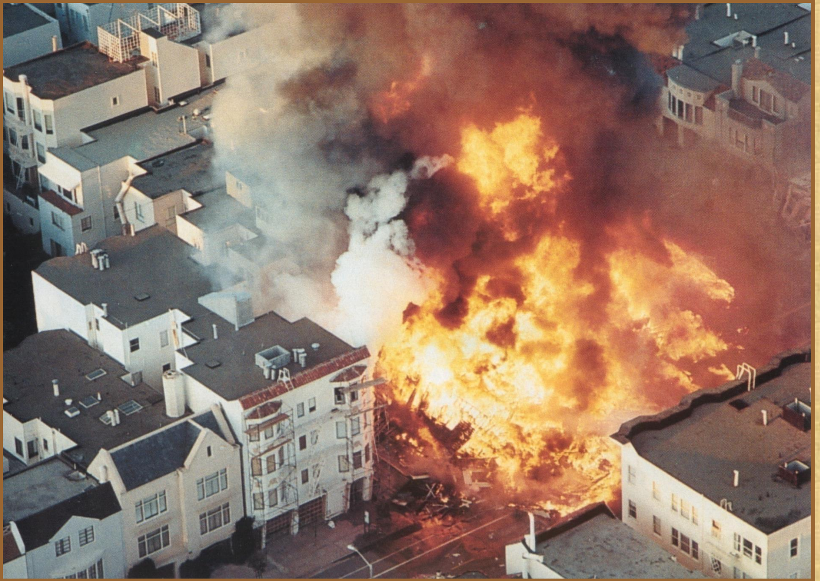
Şekil 9.18: San Francisco Marina ilçesinde 1989 Loma Prieta depremi sırasında kopan gaz hatlarının neden olduğu yangın.
