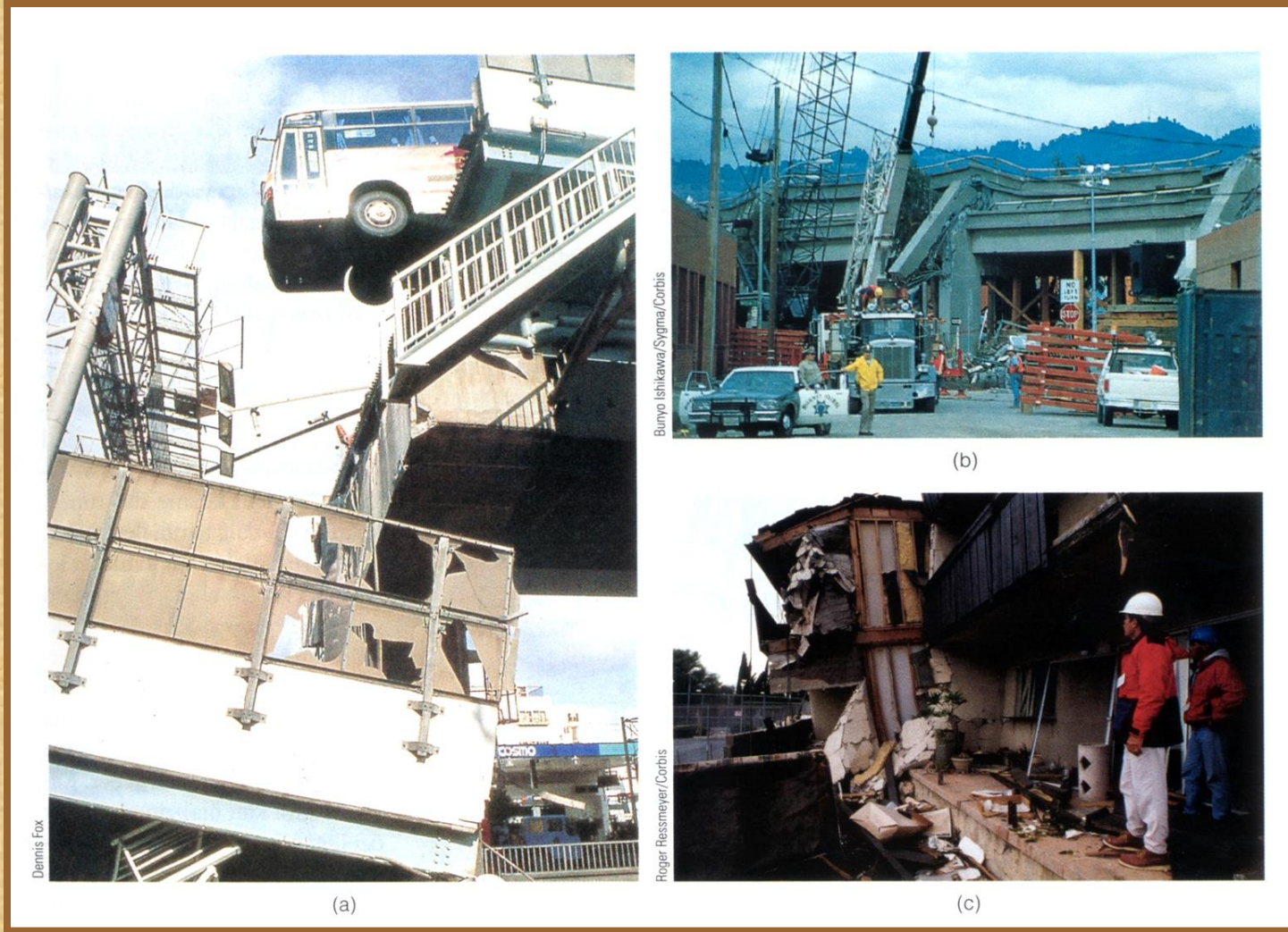
Şekil 9.6: Pasifik çevresi kuşağında deprem hasarları. (a) 5000 den fazla insanın öldüğü Japonya, Kobe'de Ocak 1995 depreminin neden olduğu hasarın bir bölümü. (b) Kaliforniya, Oakland'da Ekim 1989 Loma Prieta depreminden kaynaklanan hasar. 880 no.lu Interstate'in üst güvertesini destekleyen sütunlar yenilerek üst güvertenin alt güverte üzerine çökmesine yol açmıştır. (c) Kaliforniya, Northridge'de Ocak 1994 depreminin bir sonucu olarak on altı insanın öldüğü Northridge Meadows apartmanlarının dış yüzlerinde görülen ciddi hasar.
