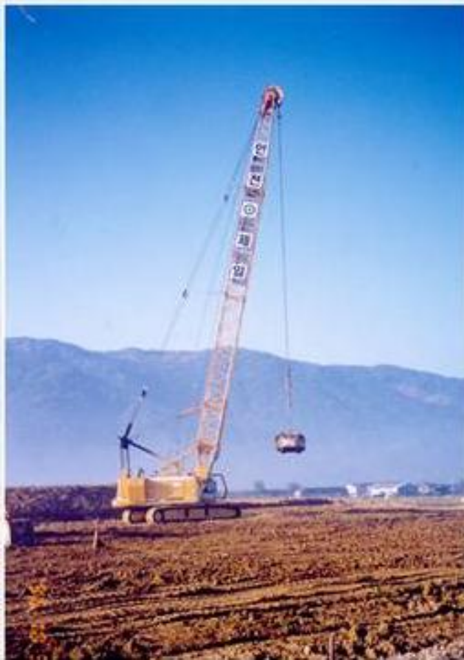
Şekil 22. Dinamik Kompaksiyon aracı ( http://www.sangjee-menard.co.kr )
