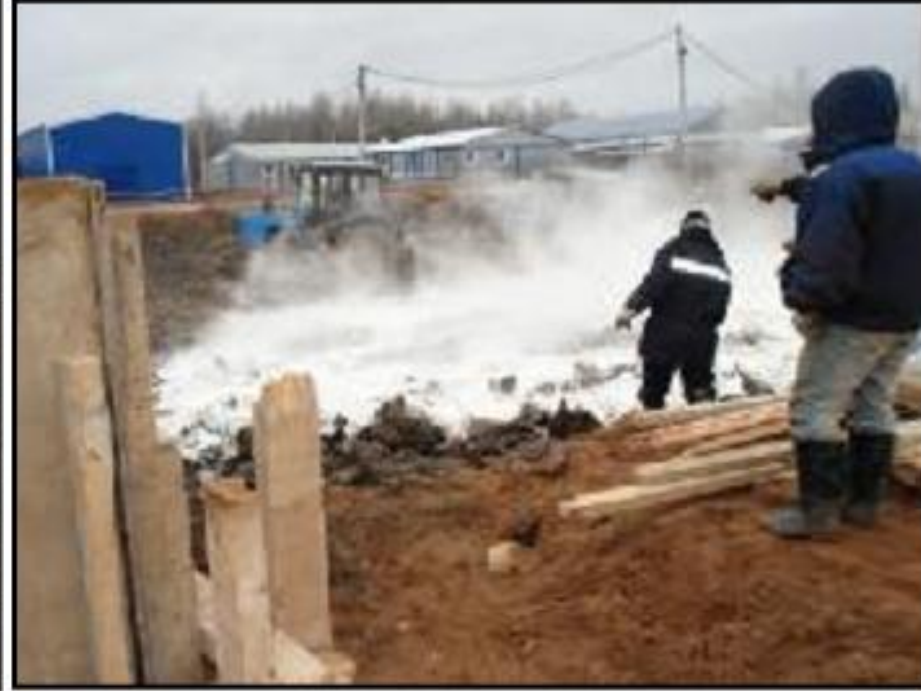
Şekil 34. Kireç serilme işlemi
