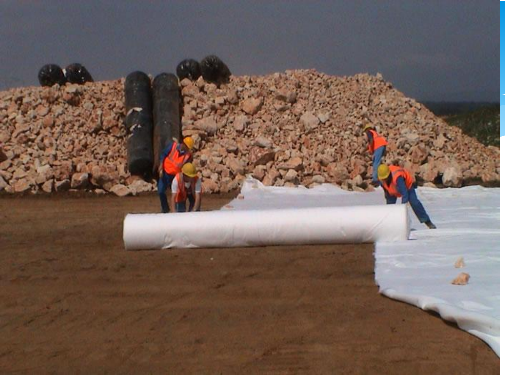
Şekil 40. Jeotekstil uygulaması
