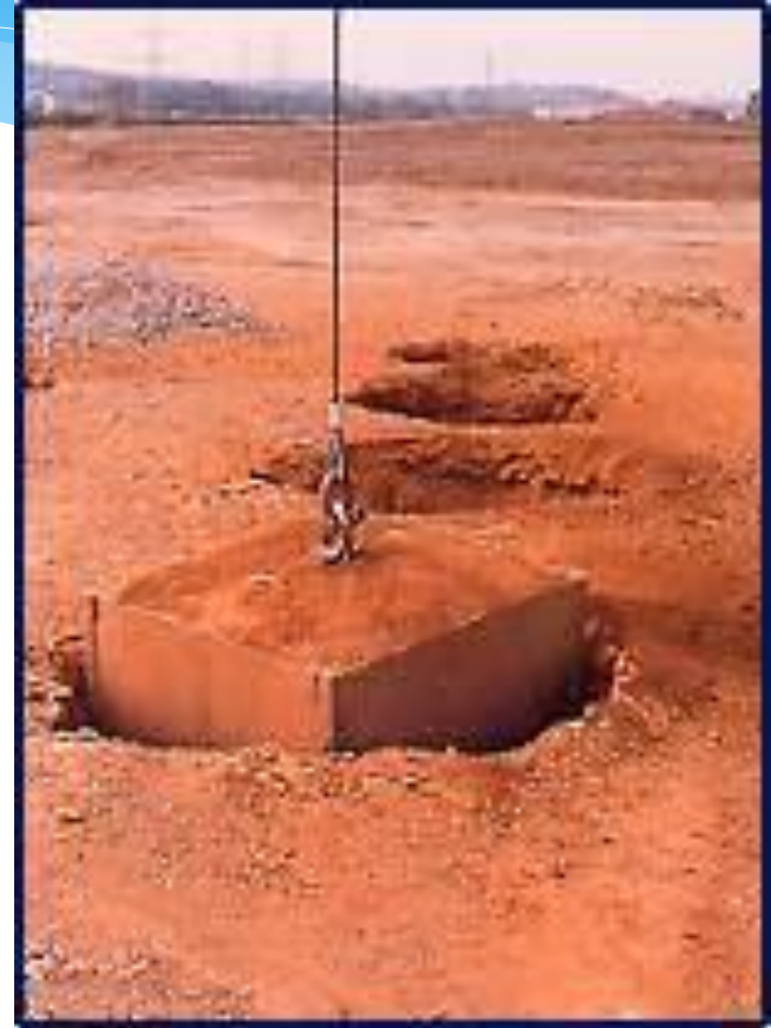
Şekil 23. Çelik veya donatılı betondan yapılan ağırlık ( http://www.keller-ge.co.uk )
