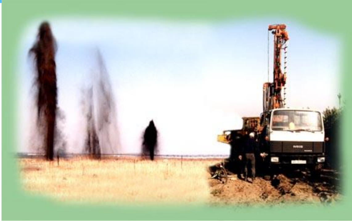
Şekil 21. Patlatma yerleştirme makinesi ve dren kuyularından fişkıran kum-su-hava karışımı ( http://www.bul.de )
