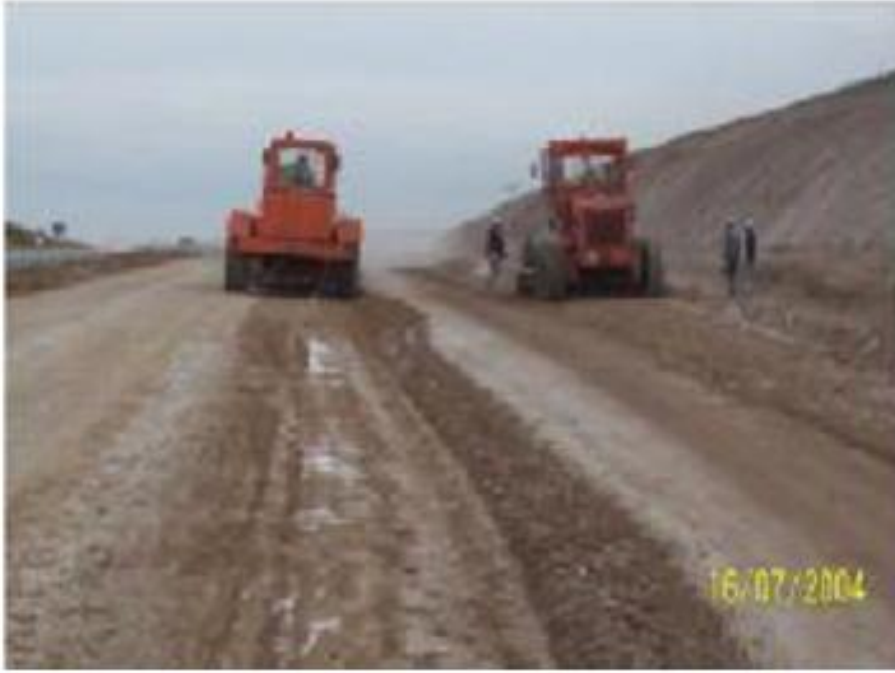
Şekil 35. Greyder ile karıştırma işlemi
