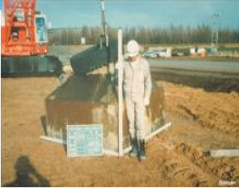
Şekil 26. Tokmak boyutlarının ölçülmesi, Hokkaido-Japan ( http://cee.engr.ucdavis.edu )
