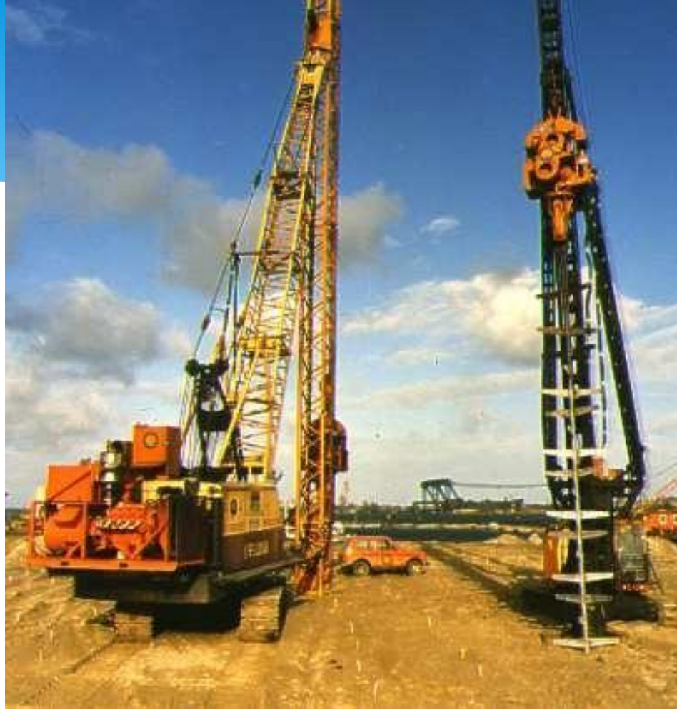
Şekil 17. Vibro-Kanat metodu [Resmin sağ tarafında kanatlı tij görülmektedir. Kanatlı tijin uzunluğu:15m, kanat uzunluğu: 80cm ve kanatlar arası mesafe: 50cm] ( http://www.geoforum.com )
