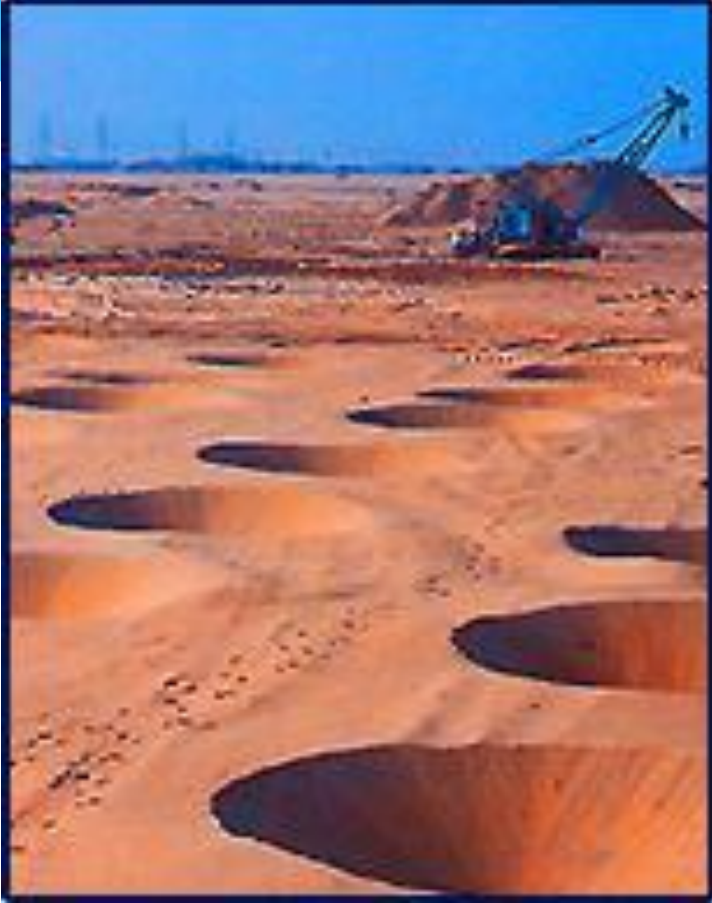
Şekil 24. Çok sayıda düşme sonucu oluşmuş çukurlar (kraterler) ( http://www.keller-ge.co.uk )
